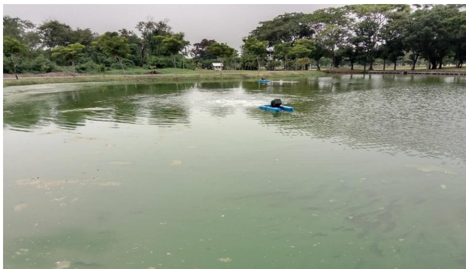
ภาพที่ 4-6 การเดินระบบ Solar aeration
