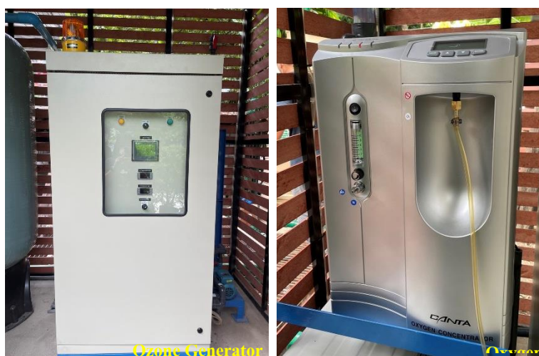
ภาพที่ 3-6 ส่วนประกอบของระบบ Ozone System
