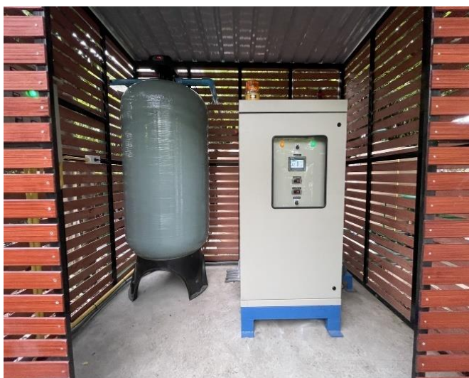
ภาพที่ 3-2 การติดตั้งอุปกรณ์ระบบ Multimedia filter และ โอโซน
