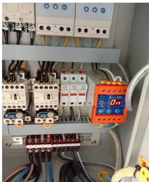
ภาพที่ 3-14 งานติดตั้งตู้ควบคุมเครื่องเติมอากาศระบบ Solar aeration pond
