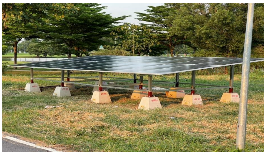
ภาพที่ 3-14 งานติดตั้งแผงโซลาร์เซลล์
