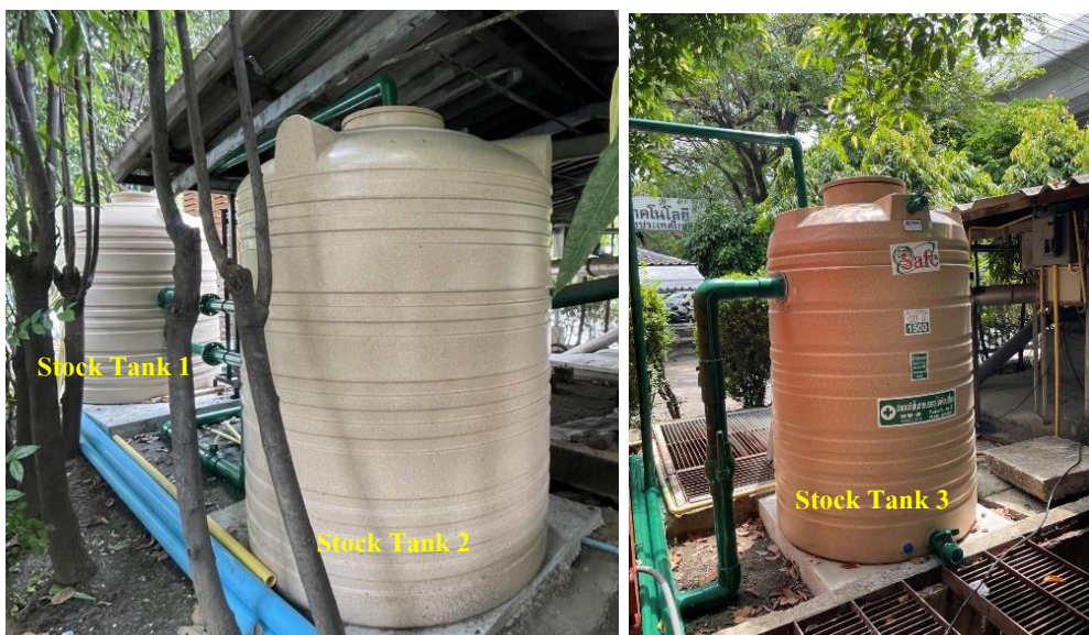
ภาพที่ 3-5 EQ Pump, Stock Tank 1-2 และ Stock Tank 3
