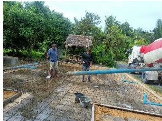
1. การตีแบบ ผูกเหล็กเส้น วางท่อระบายน้ำ
