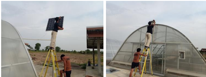
ภาพที่ 17 การทำความสะอาดแผงโซลาร์เซลล์
