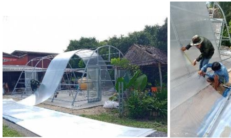
2. การติดชุด Clamping บนโครงเหล็กของระบบบ่อแห่งนี้ แล้วปิดคลุมหลังคาด้วยแผ่นโพลีคาร์บอเนต
