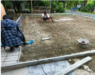
1. การตีแบบ ผูกเหล็กเส้น วางท่อระบายน้ำ
