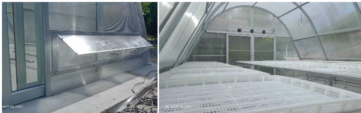
3. การติดตั้งประตูลูมิเนียมพร้อมประตูมุ้งลวดทั้งด้านหน้าและด้านหลังของระบบบ่อแห่งนี้ เปิดช่องอากาศเข้าด้านหน้า ประกอบชั้นวางผลิตภัณฑ์ ใส่ตะแกรงตาก
