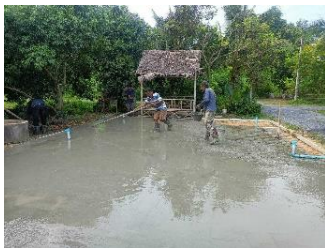
2. เทพื้นคอนกรีตพร้อมโรยปูนดำ และขีดบริเวณผิวหน้า
