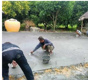
2. เทพื้นคอนกรีตพร้อมโรยปูนดำ และขีดบริเวณผิวหน้า
