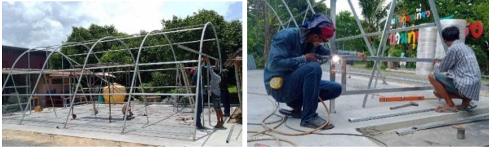
1. การติดตั้งเสาเหล็กกับโครงโค้งพาราโบลา
