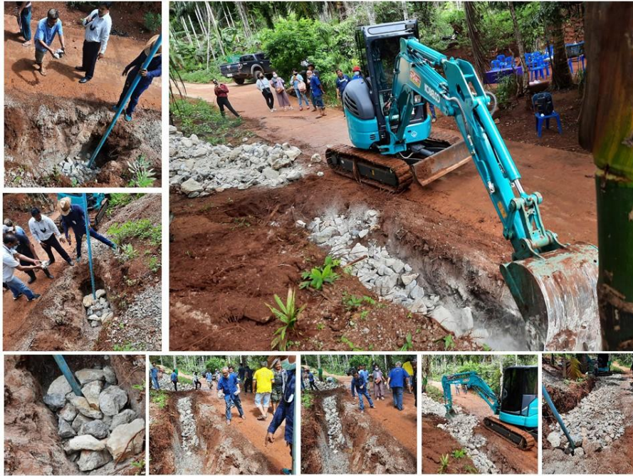
ภาพที่ 4.8 การจัดเรียงวัสดุใส่ในหลุมธนาคารน้ำใต้ดินระบบปิดโดยเริ่มจากหลุมสะดือ (ภาพถ่าย: 24 มิ.ย. 2564)
