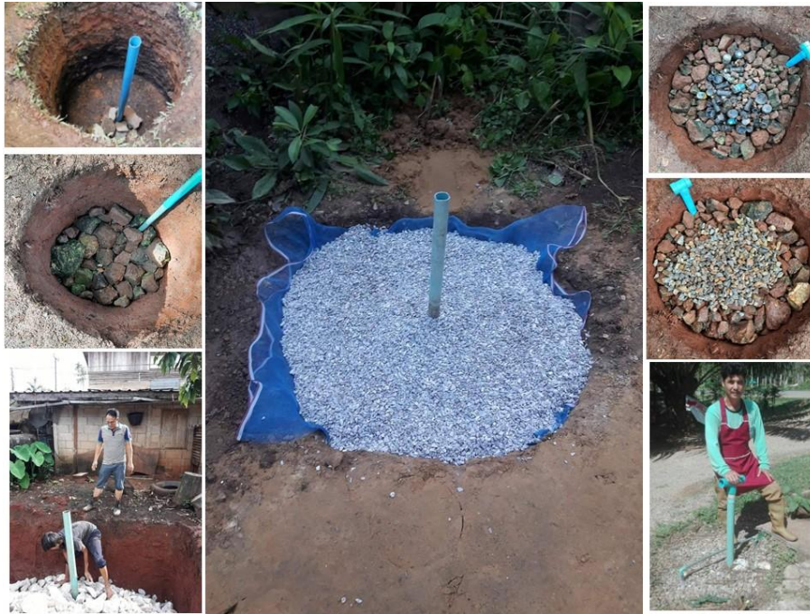
ภาพที่ 4.12 การจัดเรียงวัสดุหลุมธนาคารน้ำใต้ดินระบบปิดระดับครัวเรือน
