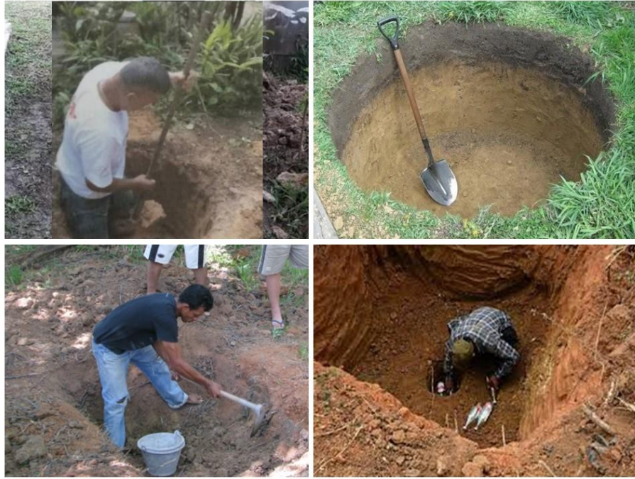
ภาพที่ 4.11 การขุดหลุมธนาคารน้ำใต้ดินระบบปิดระดับครัวเรือนโดยใช้แรงงานคน (ภาพถ่าย: 22-30 มิ.ย. 2564)
