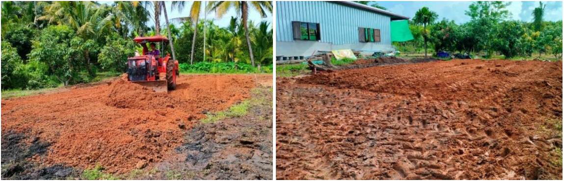
ขั้นตอนการปรับพื้นที่ และถมดินเพื่อรอการเทพื้นที่เป็นฐานรองรับระบบอบแห้ง
