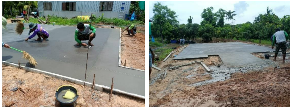
ขั้นตอนการขัดพื้นผิวหน้า แกะแบบ และพื้นดำสำหรับเป็นฐานรองรับระบบบอบแห้งฯ ที่เสร็จสมบูรณ์
