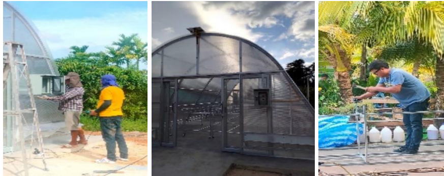
ติดตั้งตู้แสดงอุณหภูมิและความชื้นสัมพัทธ์ และต่อชั้นวางผลิตภัณฑ์
