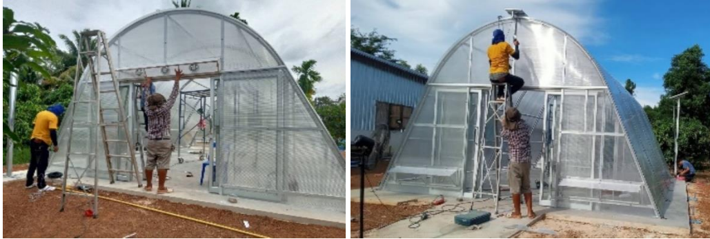
ติดตั้งระบบระบายอากาศ เสาแผงโซลาร์เซลล์
