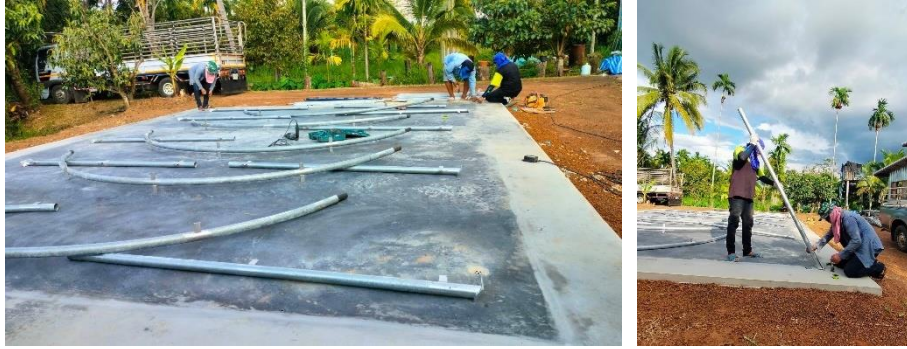
ขั้นตอนติดตั้งเสาเหล็กกับโครงโค้งพาราโบลาโดยใช้ทุจจะยึดลงบนฐานพื้นคอนกรีตหลังจากวัดระยะ
