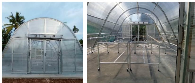
ระบบอบแห้งพลังงานแสงอาทิตย์ที่ติดตั้งเสร็จสมบูรณ์
