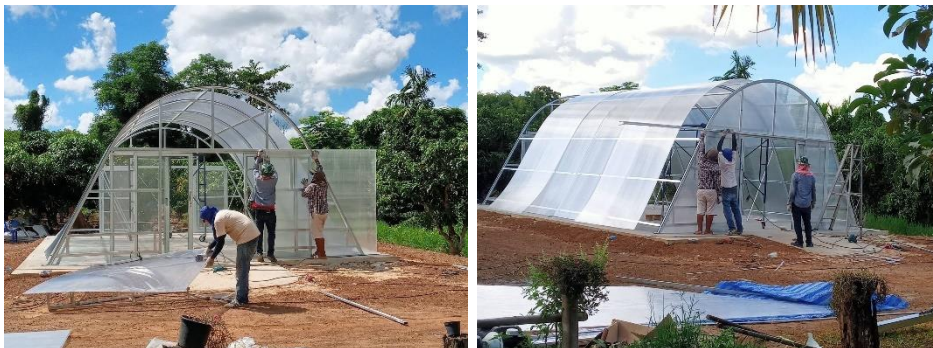
ขั้นตอนการติดตั้งชุดอุปกรณ์จับยึด หรือ aluminium clamping บนโครงเหล็กของระบบบอบแห้งฯ และปิดคลุมหลังคาด้วยแผ่นโพลีคาร์บอเนต
