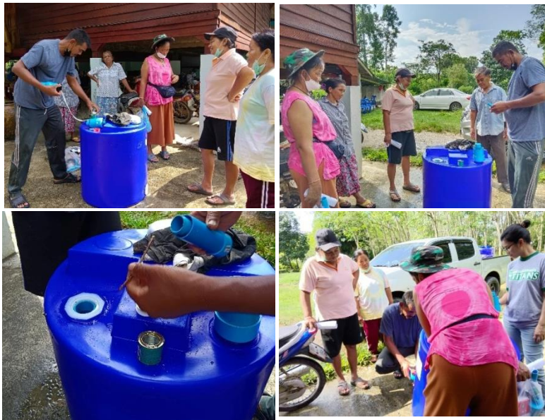
รูป 17 สาธิตการติดตั้งส่วนประกอบต่างๆ ของระบบผลิตปุ๋ยชีวภาพแบบไร้อากาศ
